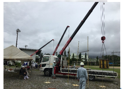
小型移動式クレーン
