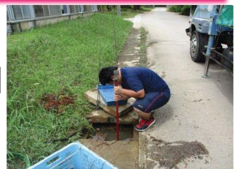
排水溝の蓋を取り外し、体積土壌を調査&計測
