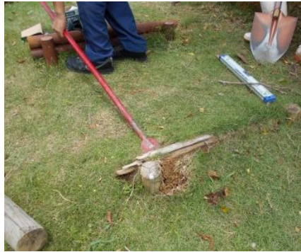
朽ちている階段を新しく作り直します
