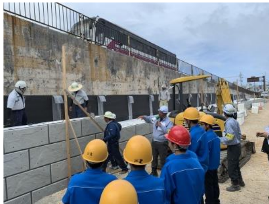
林業緑地科1年生が、仲本工業建設現場(本部大橋)を見学時に撮影した写真が、沖縄県建設業協会主催
